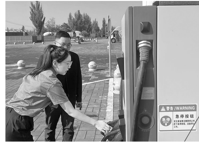
近日,青铜峡市检察院干警实地核查新能源充电桩,排查充电设施安全隐患。
