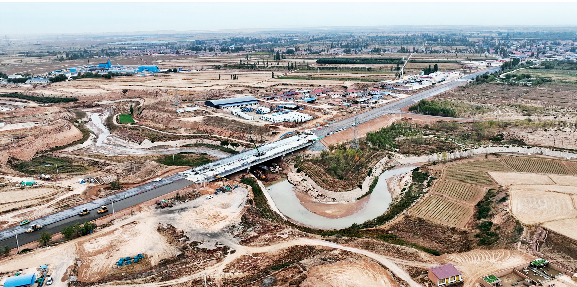
在吴忠市红寺堡区红寺堡镇团结村城西至G338连接线项目现场,工人开展收尾施工作业(摄于10月15日)。
