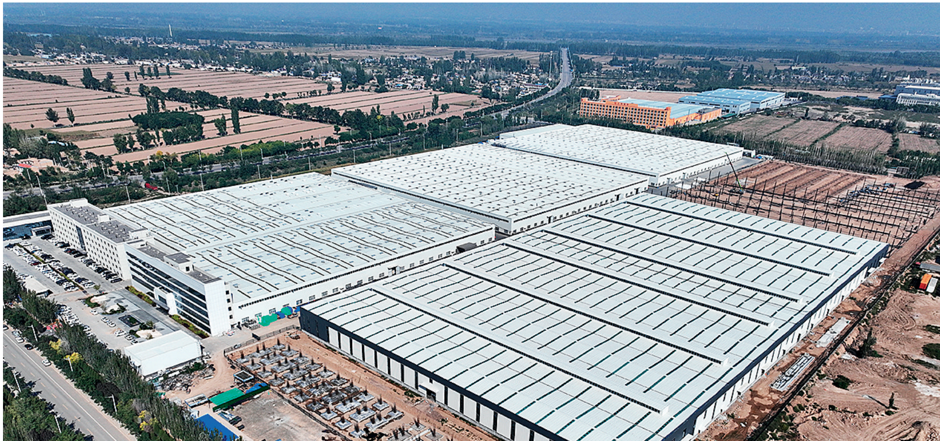
宁夏麟嘉实业发展有限公司年产10亿只塑料编织袋、食品级包装袋及薄膜新材料项目自今年开工建设以来,企业全力加快工程建设进度,目前项目一车间进入设备安装阶段(摄于9月22日)。
