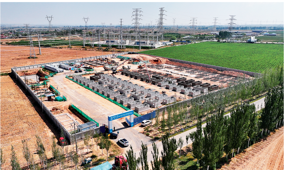
吴忠市融晟全利新能源有限公司100MW/400MWh独立储能电站项目正在加快建设(摄于9月20日)。项目建成投运后,可有效平抑新能源发电波动,推动本地风光资源高效开发利用。
