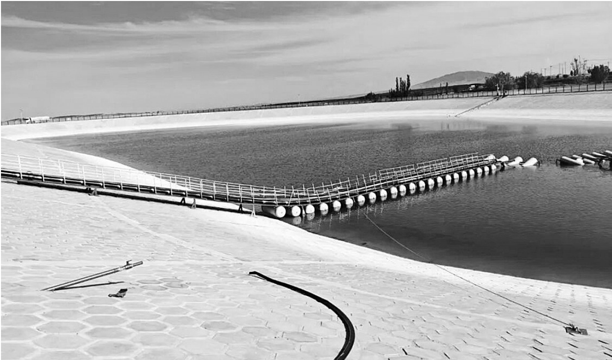
9月14日,吴忠市利通区孙家滩片区高标准农田配套基础设施改造(一期)工程全面投用。
