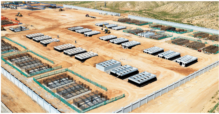
在宁夏恒源锂创新能源科技有限公司同心县丁塘300MW/1200MWh共享储能电站示范项目建设现场,各类机械加紧施工,储能区正有序开展储能基础施工。项目建成投用后,将为当地风电光伏新能源装上“超级充电宝”(摄于9月4日)。
