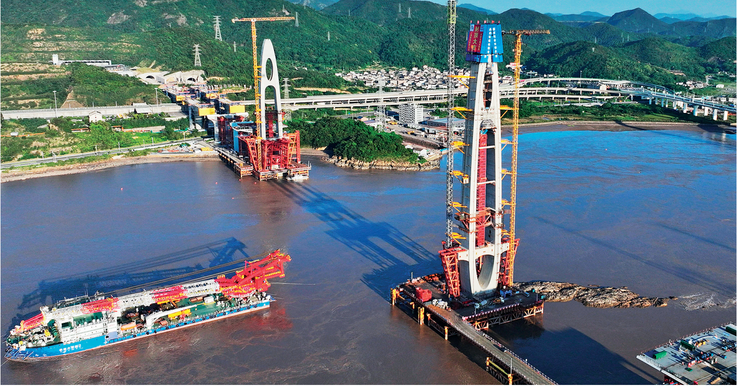
甬舟铁路全线跨海大桥六座主塔全部封顶
