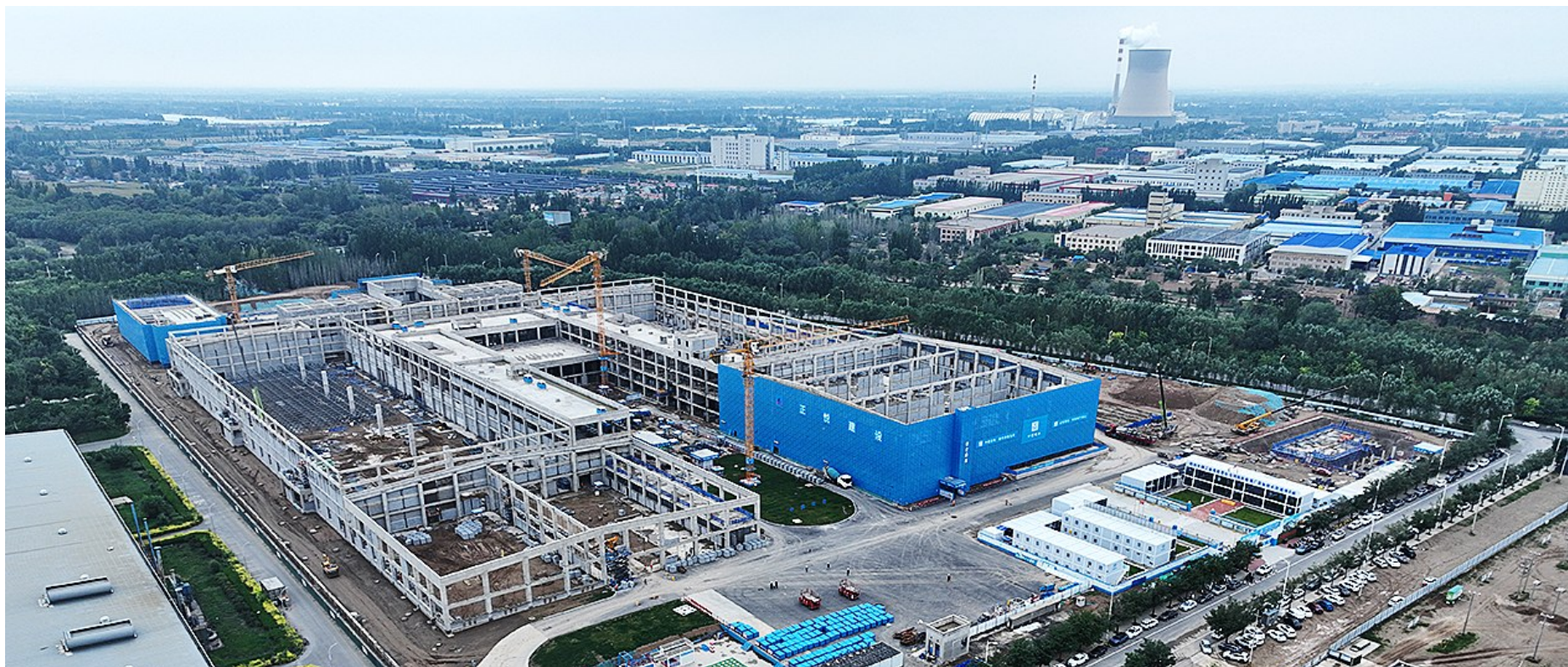
在湖南中烟吴忠卷烟厂易地技术改造项目施工现场,一座座厂房主体框架拔地而起,各项施工作业有序推进(摄于9月9日)。
