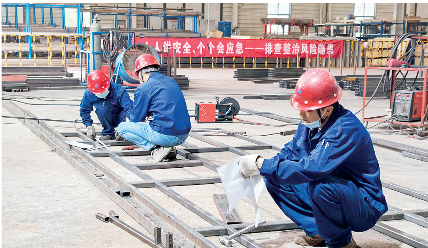
在宁夏思达机械有限公司生产车间，工人核对图纸进行钢架焊接工作（摄于9月4日）。
