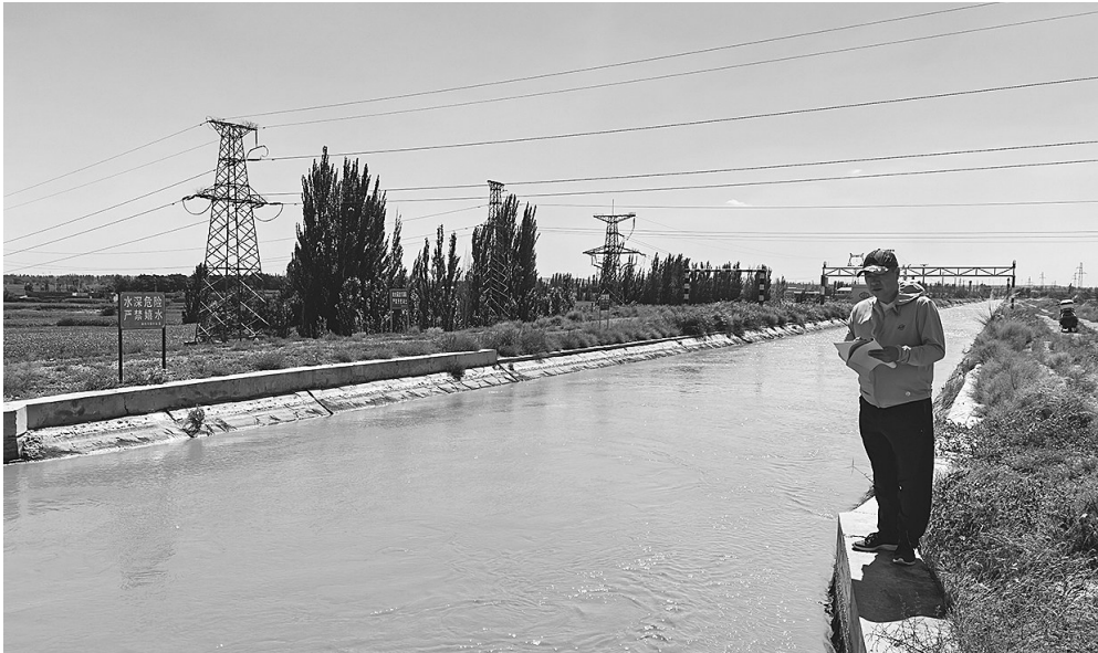
9月2日,在吴忠市利通区扁担沟扬水一千渠道,巡护人员查看、记录渠道输水运行情况,全力做好渠道巡查管护。
