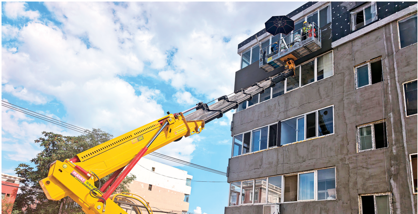
8月25日,吴忠市利通区金星镇金塔社区地区大院小区北院改造现场,工人加紧外墙保温施工。马慧 李金汰 摄
