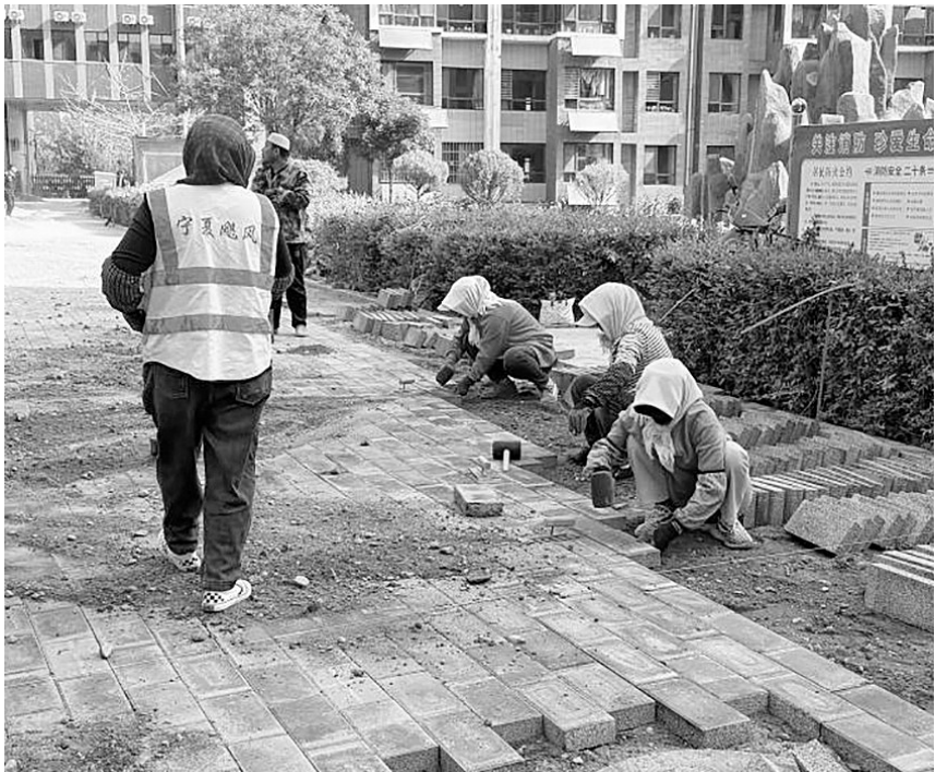
近日,在吴忠市利通区金星镇明珠社区恒昌新天地小区,工人翻新路面。
