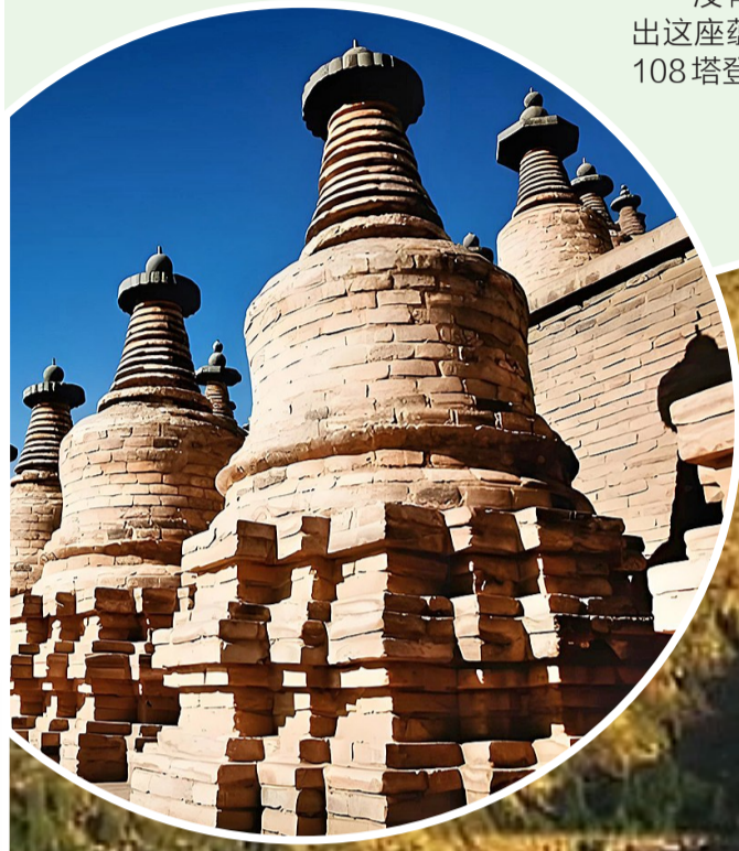
108塔的结构为砖砌结构,内为土坯,外为青砖垒砌,所有的塔均由塔座、塔身、塔刹组成。
