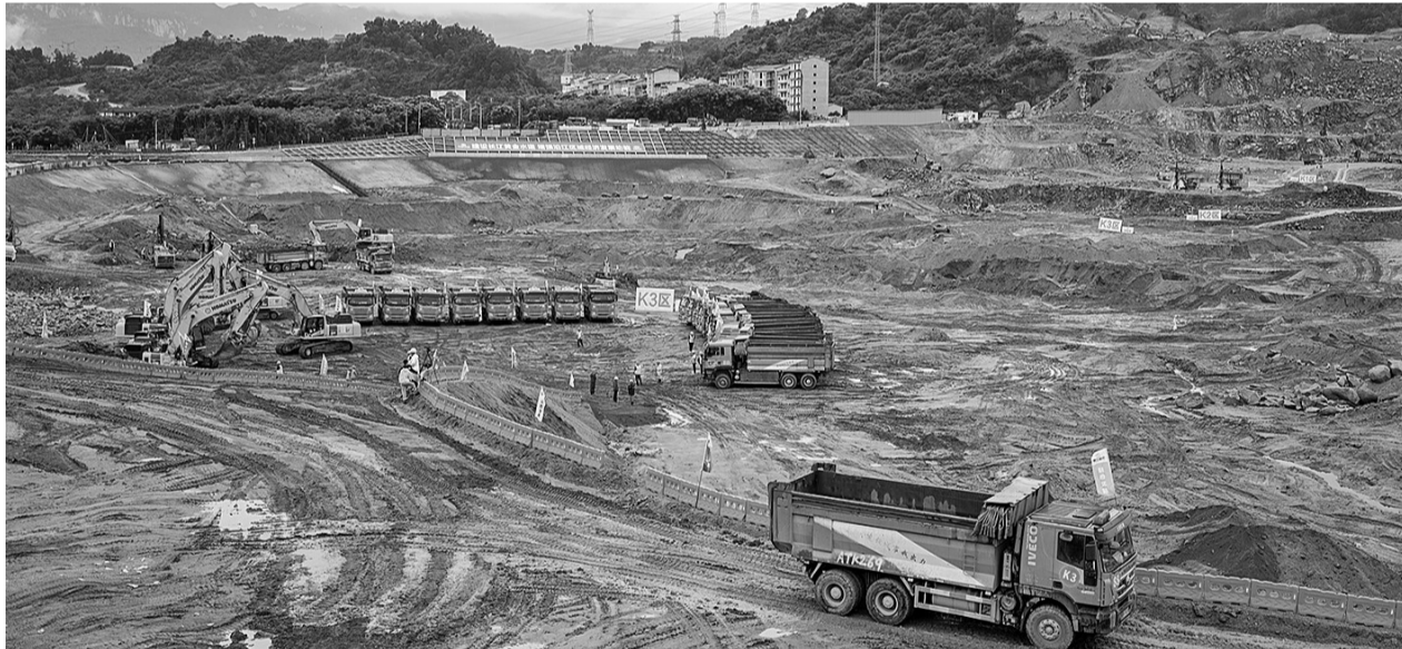
三峡水运新通道工程先行开挖区施工现场(摄于6月8日)。
