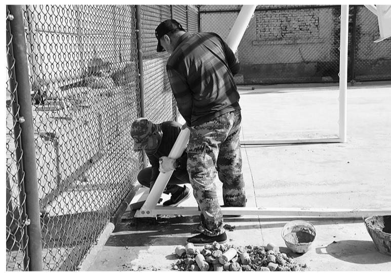
近日,在吴忠市利通区胜利镇民生社区西湖小区北侧多功能运动场项目现场,施工人员在安装运动设施。
