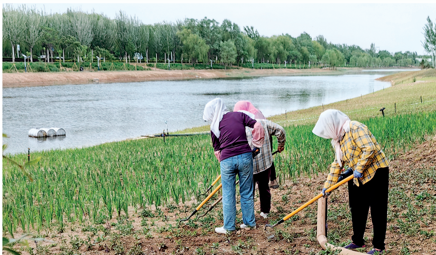
5月16日,工人在吴忠市城南水系生态修复工程二标段除草。
