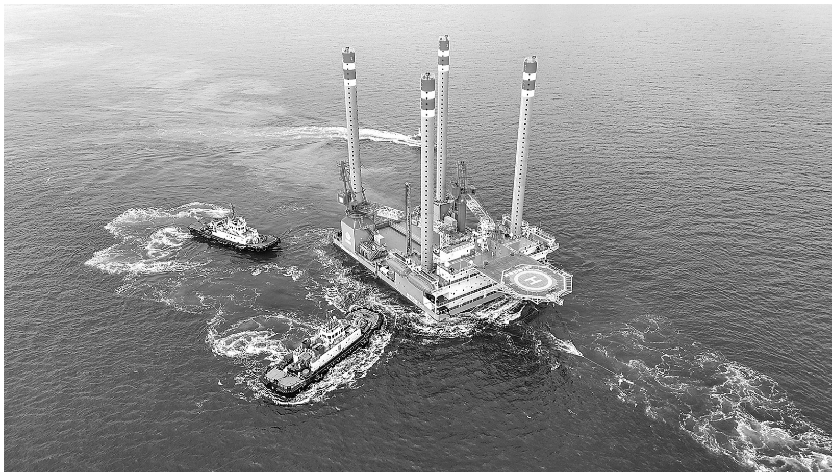
5月14日，我国首座海上移动式多功能措施平台“海洋石油283”从青岛西海岸新区启运。当日，我国首座海上移动式多功能措施平台“海洋石油283”（又称“增产一号”）从青岛西海岸新区启运，发往渤海油田。该平台采用“移动式+模块化”设计，总重7300余吨，最大作业水深40米，集酸化、压裂、调驱、调剖、稠油热采等功能于一体，并引入AI智能监测，投用后将有效支撑渤海油田增储上产。
