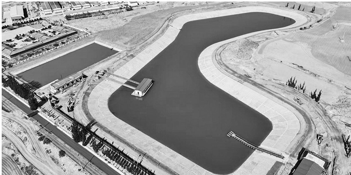
5月7日,吴忠市利通区孙家滩片区高标准农田基础设施改造(一期)工程四千2号蓄水池已基本完工,进入投运调试阶段。
