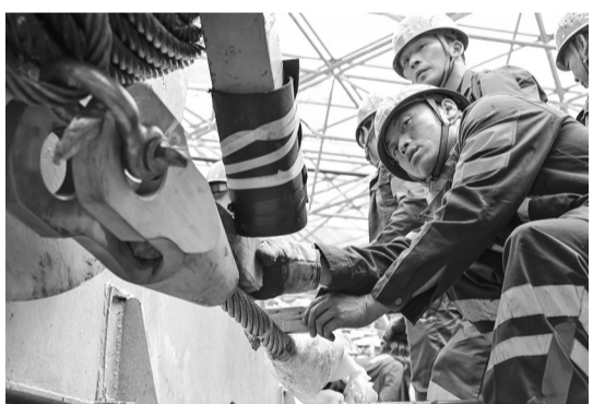
5月6日，工作人员更换馈源轮的锚固接头。新华社发
