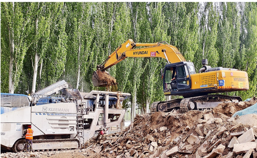
近日,在青铜峡市叶盛镇联丰村,一台大型移动式破碎机将废旧混凝土板破碎。
