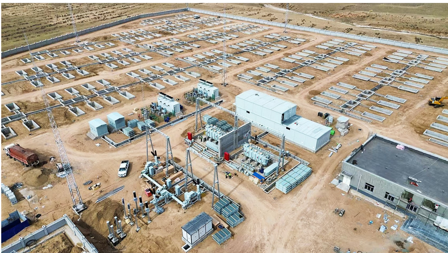
盐池县耀泰光伏发电有限公司275MW/1100MWh储能发电项目土建施工已完成95%,55套储能设备基础全部浇筑完毕,施工人员正加紧开展电缆敷设作业(摄于4月13日)。
