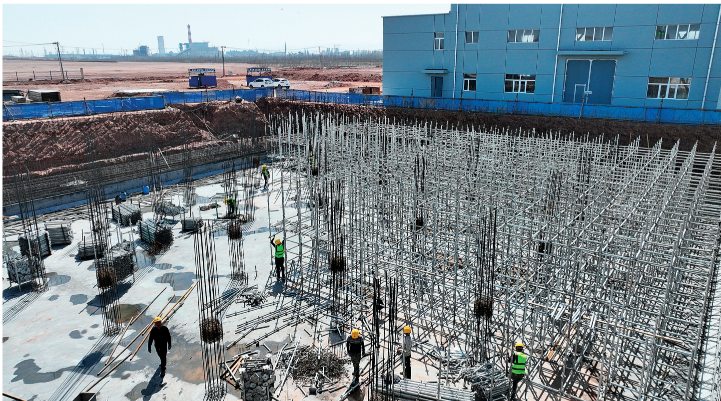
在宁夏中鑫元新材料科技有限公司30万吨/年聚甲醛(POM)项目现场,施工人员正在进行应急水池钢筋绑扎作业(摄于3月31日)。
