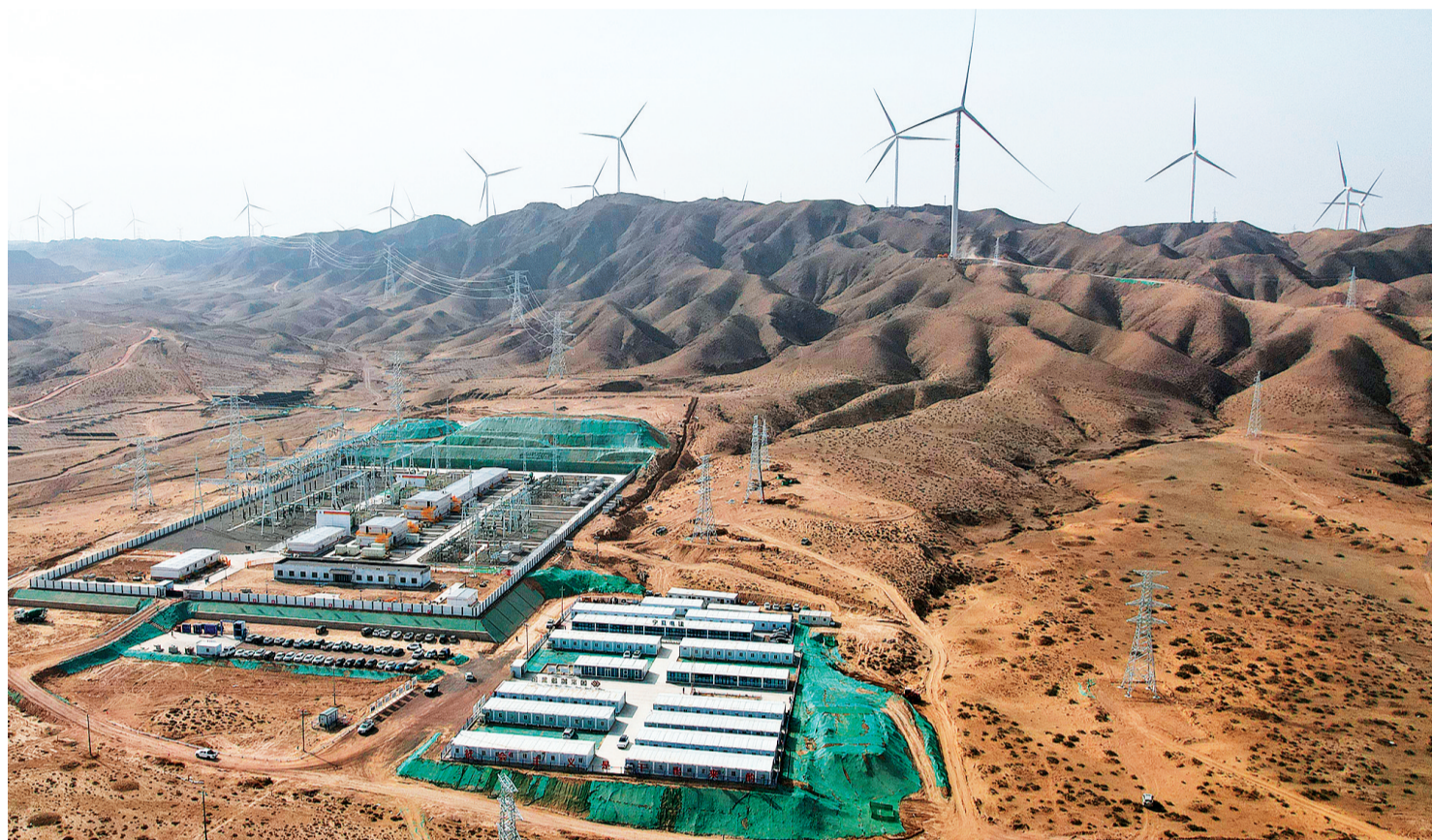
国能宁湘直流水光互补150万千瓦风光同场基地项目现场风机矗立,集风电、光伏、储能于一体,项目建成后,将把荒漠风光转化为清洁电能,以绿色动能赋能区域高质量发展(摄于3月31日)。
