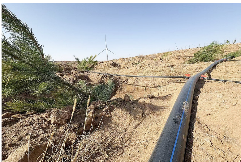
提前铺设好的滴灌带为植树造林做好后续浇灌工作。
