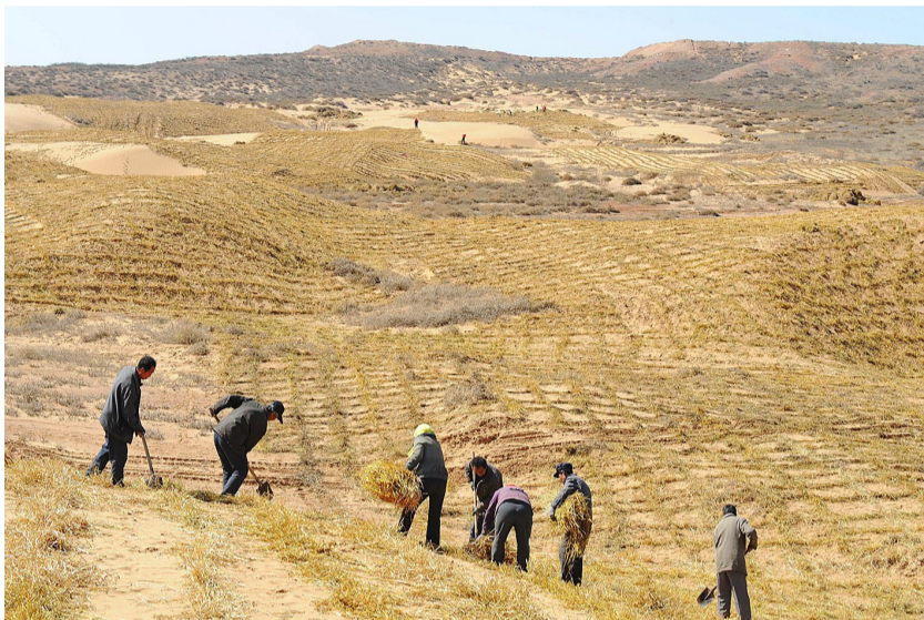
盐池县沙边子综合治理区，工人们压设草方格以形成网状沙障(资料图)。
