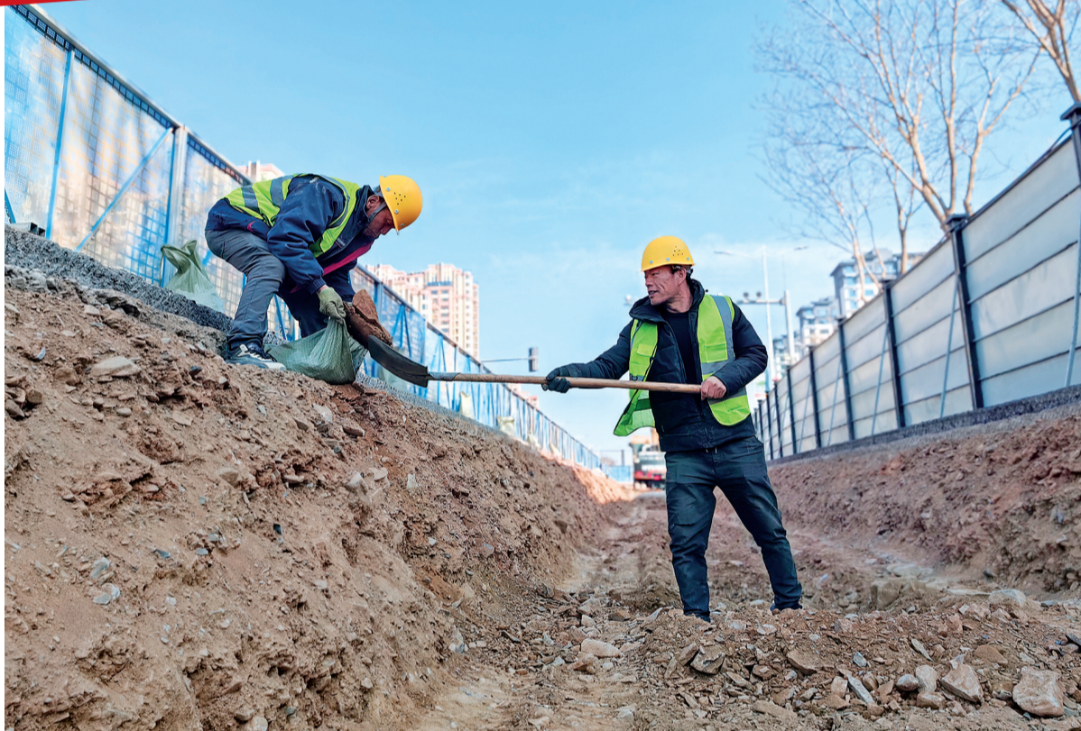
↑在吴忠市利通区富平街排水防涝项目现场,工人在清理沟槽(摄于3月16日)。
