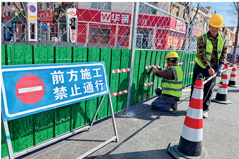
在吴忠市利通区安居路,工人进行施工前的道路安全警示布设工作(摄于3月10日)。
