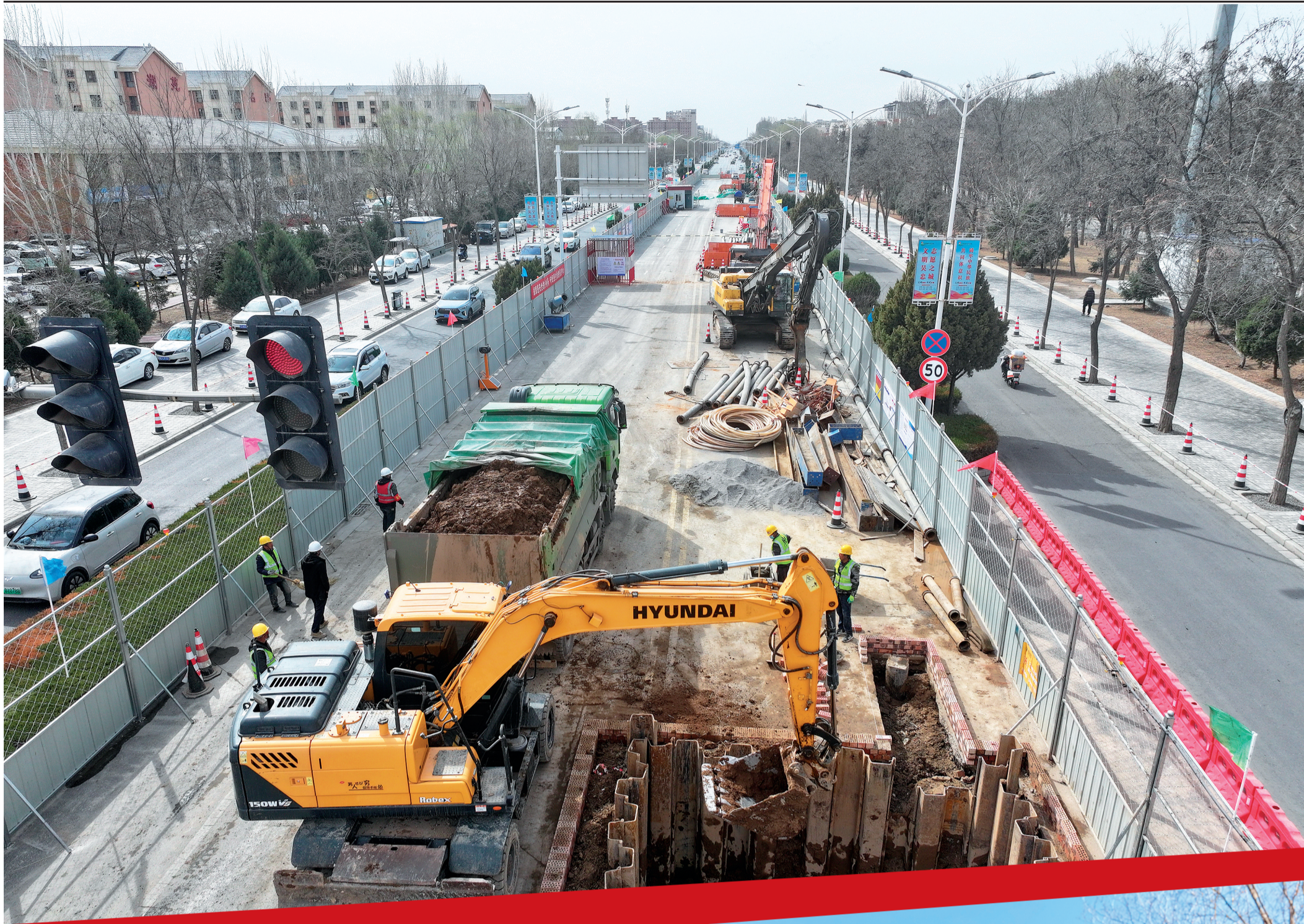
在吴忠市利通区利华北街排水防涝项目施工现场,大型机械进行钢板桩支护作业(摄于3月16日)。
