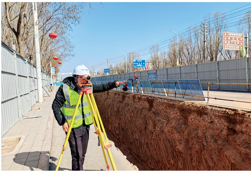
在吴忠市吴灵路片区雨污分流改造项目现场,技术人员进行管道安装起平作业(摄于3月19日)。
