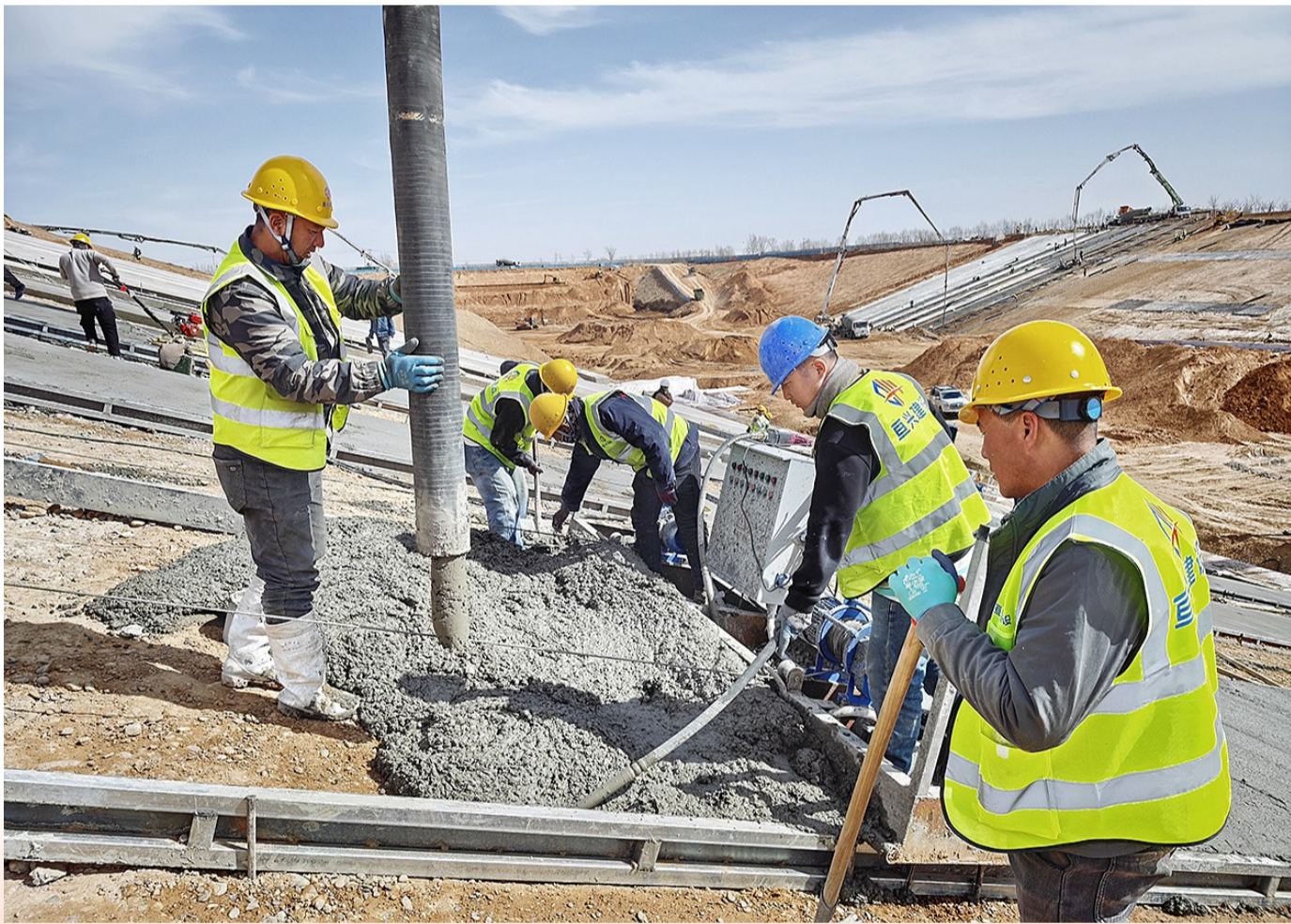
3月18日,在利通区孙家滩片区高标准农田配套基础设施改造(一期)项目施工现场,施工人员进行蓄水池坡面混凝土浇筑作业。
